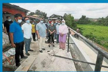
士拉央区国会议员梁自坚（中）和万隆州议员蔡伟杰（左二）在疫情期间，一起巡视煤炭山巴刹巷的斜坡提升工程进展。
